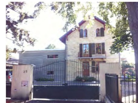
155.4 Extension de villa
